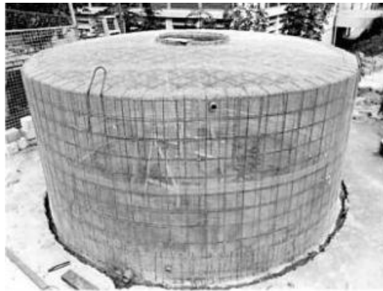
Gráfico 18. Armadura de un tanque de ferrocemento para la recogida de agua de lluvia.
