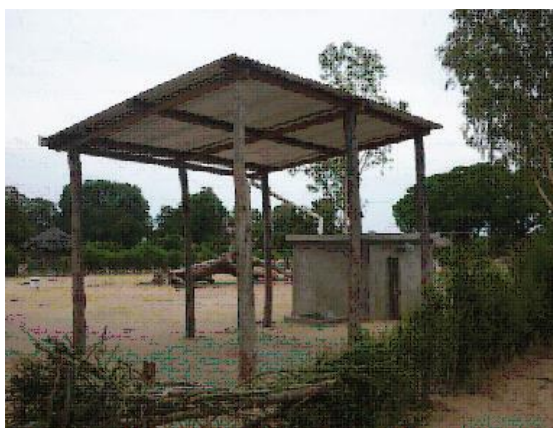
Gráfico 1. Techo y tanque para captación de agua de lluvia (localidad de Manhiça, Mozambique) construido por Intermon-Oxfam. Fuente: ESF, 2009.
