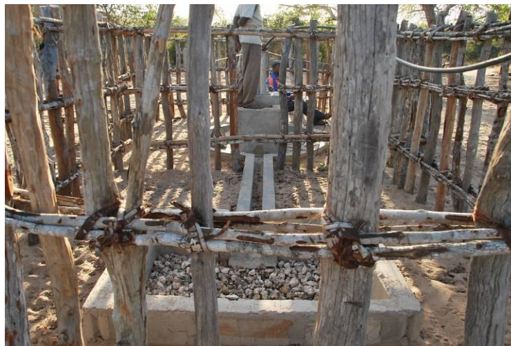
Gráfico 13. Bomba manual con paseo y dreno en Funhalouro, Mozambique. Fuente: ESF, 2012.
