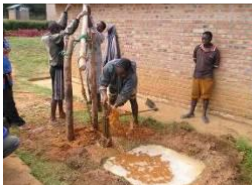
Gráfico 11. Método de perforación manual con Rota sludge y cabeza de corte.
