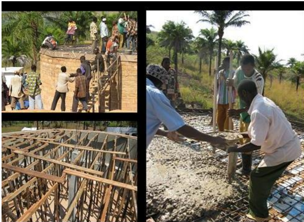
Gráfico 4. Tanque de distribución en Kigoma (Tanzania). Material: bloques de hormigón hechos in situ, solera y cubierta de hormigón armado. Fuente: ISF
