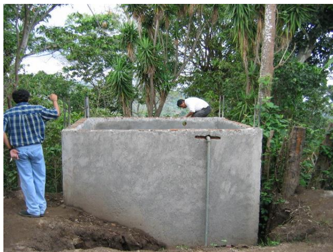
Gráfico 2. Tanque rompe-presión. Proyecto de abastecimiento de agua en la comunidad de Nazareth (El Salvador). Fuente: ESF
